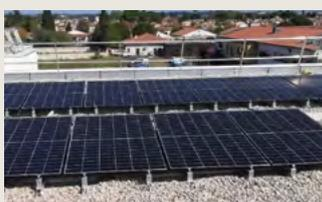
Il est particulièrement performant d'un point de vue énergétique avec la mise en place de moquettes équipées de capteurs solaires thermiques pour l'ECS et de panneaux solaires photovoltaïques dont la production est intégralement autoconsommée. Le bâtiment est alimenté par trois pompes à chaleur air/eau qui assurent une production de chaud et de froid à faible impact carbone.
